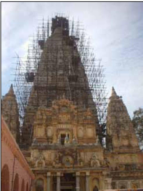
工事中の大塔(2006 年 3 月)
